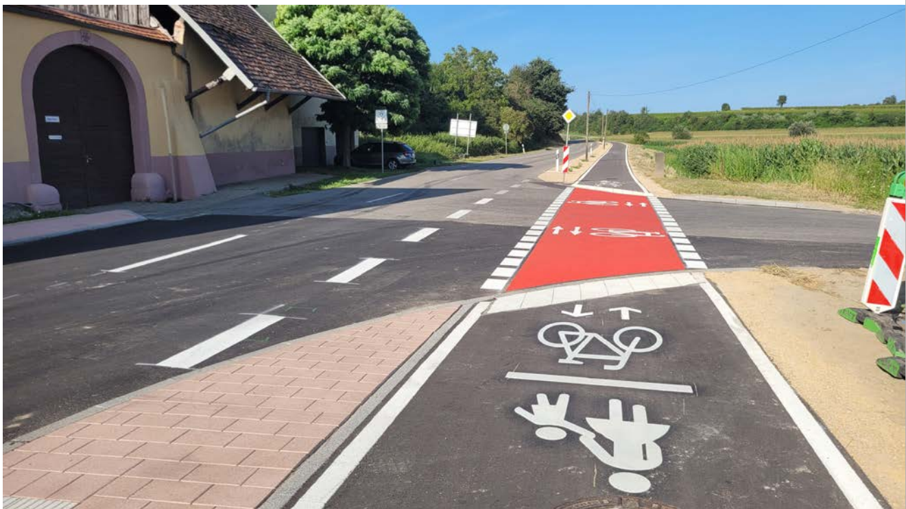
Neu gebauter Fuß- und Radweg Merdingen – Waltershofen
