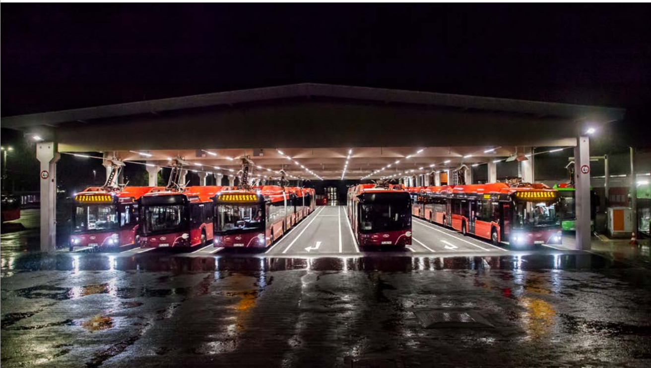
Halle für E-Busse am Betriebshof © AnjaThölking
