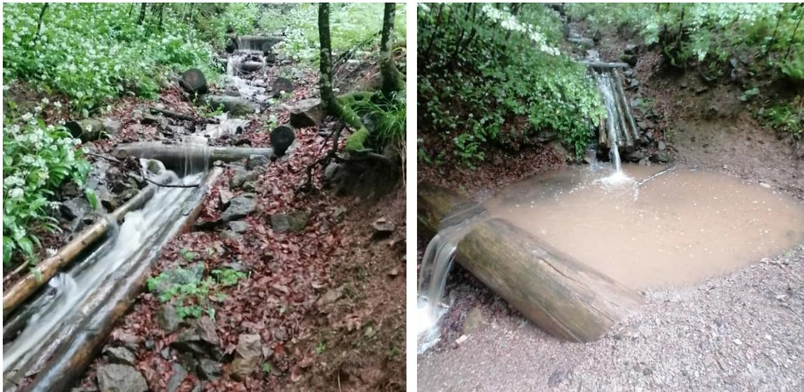
*Abbildung 3: Verringerung der Geschwindigkeit des Wegeabflusswassers durch einfache Gefälleestufen im Revier Schauinsland (Fotos: P. Schell)*
